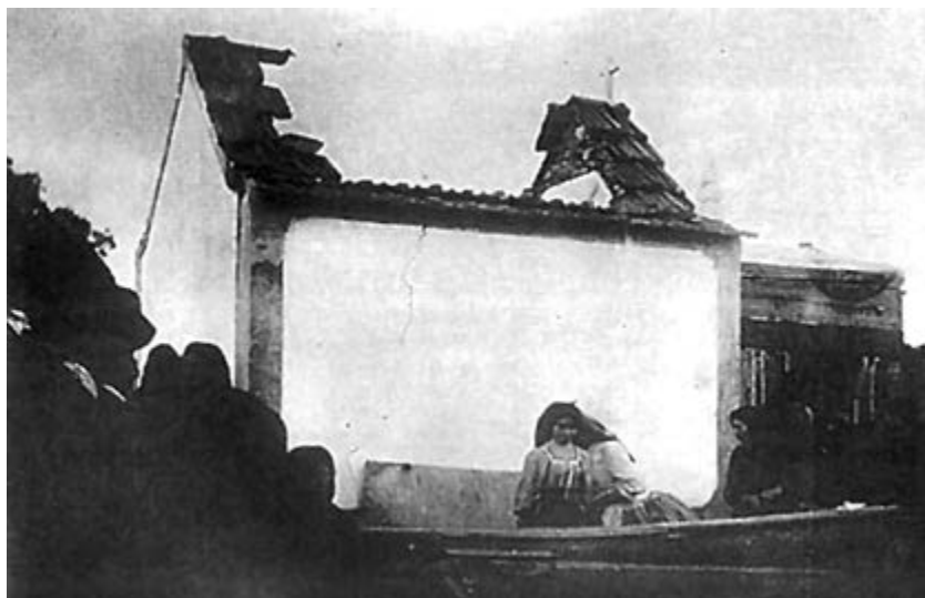
6 de marzo del 1922: La primera capillita de las apariciones fue detonada con dinamita colocada por extremistas anticlericales y masones. La capilla presente fue construida sobre el sitio de las ruinas.
